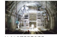
トンネルの補修工事の様子
