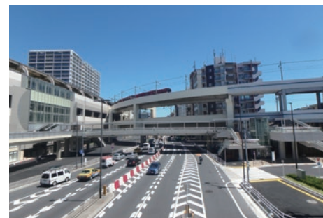
京急蒲田駅付近 国道15号線交差点部
