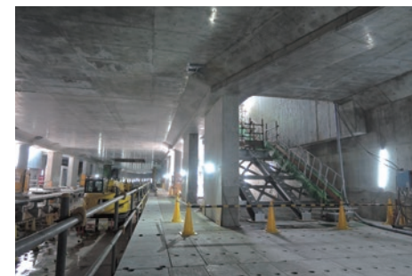
産業道路駅付近での躯体構築状況
