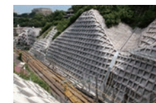
法面防護工事
