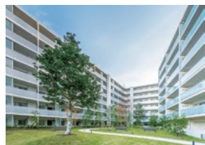
竣工写真(2017年12月撮影)
